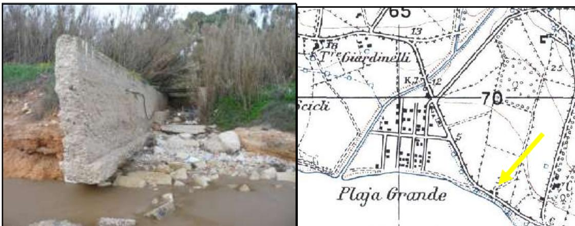
Foto a sinistra: tratto terminale canale pluviale della SP n° 89, si notano i livelli prevalentemente rocciosi arrossati a destra e a sinistra della struttura. Sullo sfondo, oltre il canneto, e quindi ben lontano dalla costa, si intravede il nastro viario. Immagine a destra, stralcio carta IGM 1967, si nota che in questo punto la spiaggia è sempre stata poco profonda.
