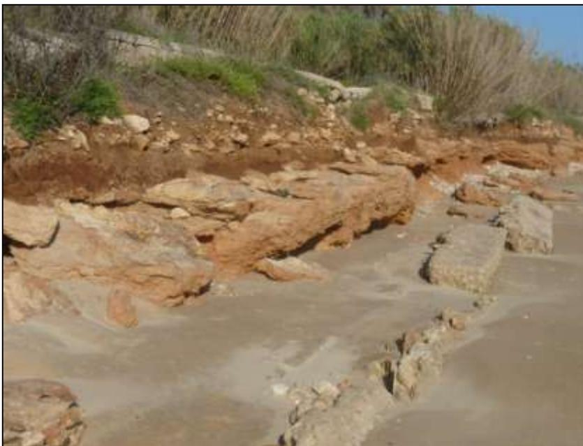
Inizio del sentiero pedonale, è possibile notare un livello roccioso estremamente cementato alla base, mentre il sentiero (visibile in alto ) si fonda sul livello superiore costituito da top-soil. A destra in basso, tracce del piccolo muretto crollato.
