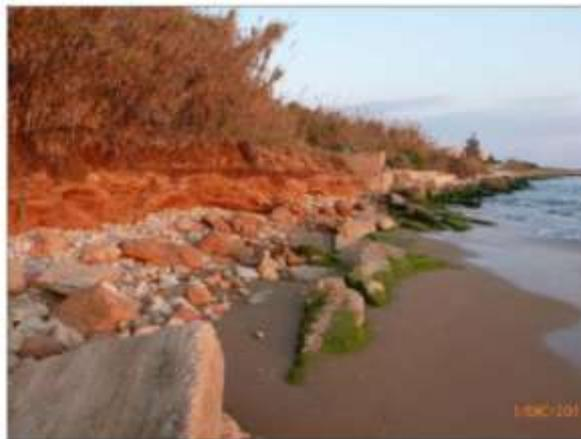
Figura 2.8 – Estremità orientale spiaggia sabbiosa di Playa Grande: muro di sostegno viabilità crollato
