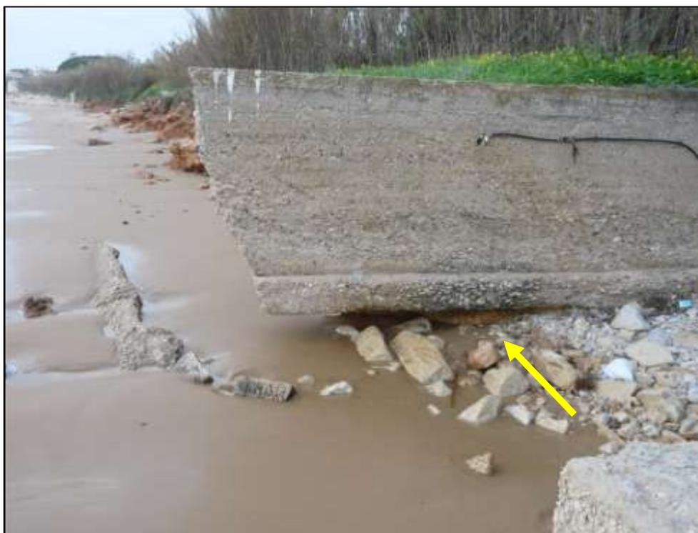
Visione laterale del tratto terminale del canale pluviale, da notare che, nella parte sinistra, il locale abbassamento dell'arenile ha causato un fenomeno di scalzamento al piede.
